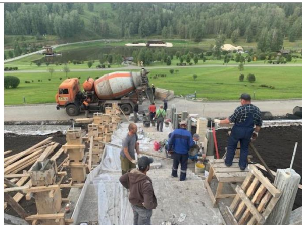
Участок 1.2. Облицовка подпорной стены рваным камнем. Монтаж мраморного парапета.
