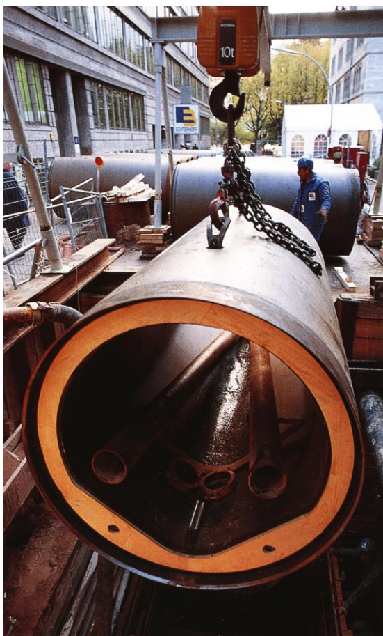
Рис. 1.1.5. Труба из полимербетона со специальным профилем
