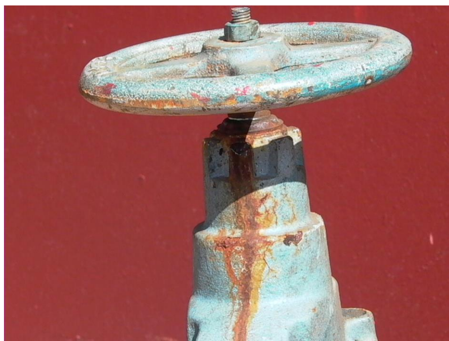
Рис. 1.2.6. Неполное закрытие маховика задвижки из-за перекоса клина
