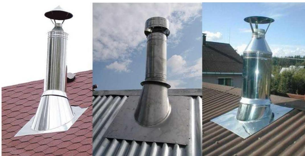
*Рис 4.25. Узел прохода вентиляции через кровлю*
