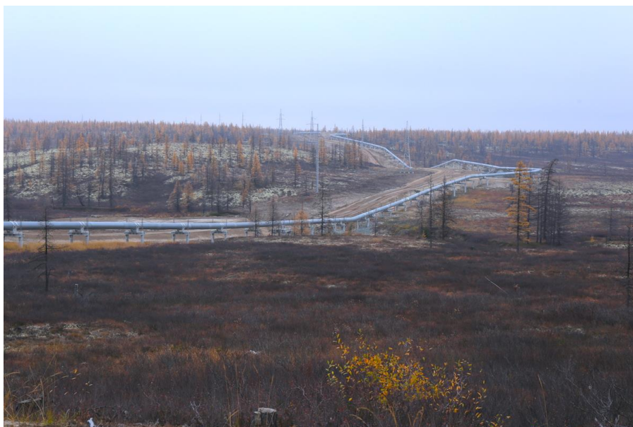
Рис.1 Нефтепровода на сваях — «Заполярье-Пурпе».
